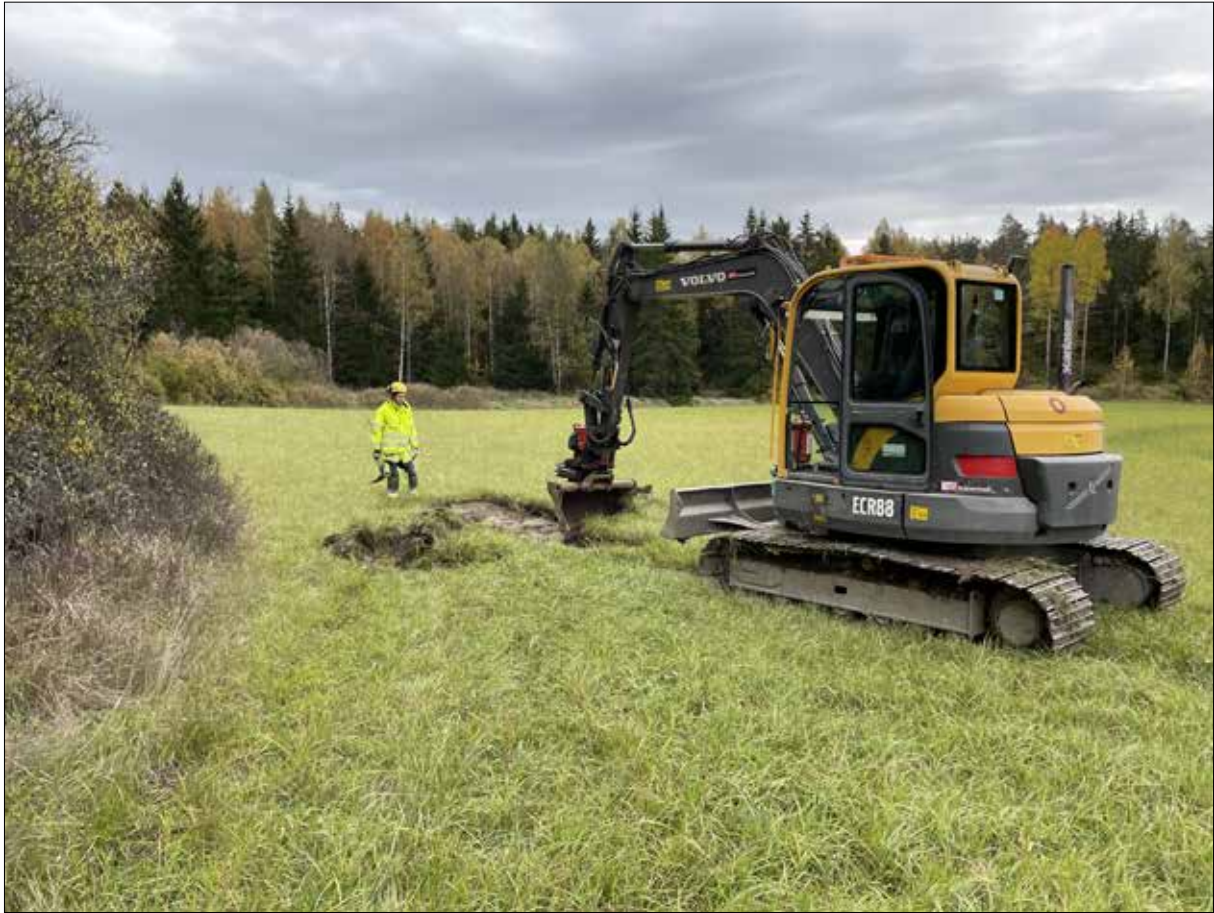
Figur 22. Översikt och arbete pågår vid objekt 3, Michael Schneider schaktar. Från väster.
