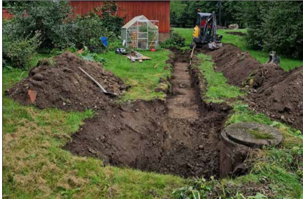
Figur 12. Översikt som visar schakt 2. Foto från söder.
