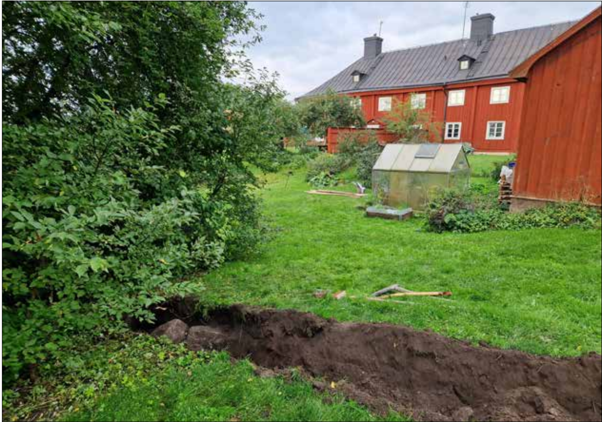
Figur 10. Del av schakt 1 med grundstenarna, A3, till vänster. Foto från nordöst.
