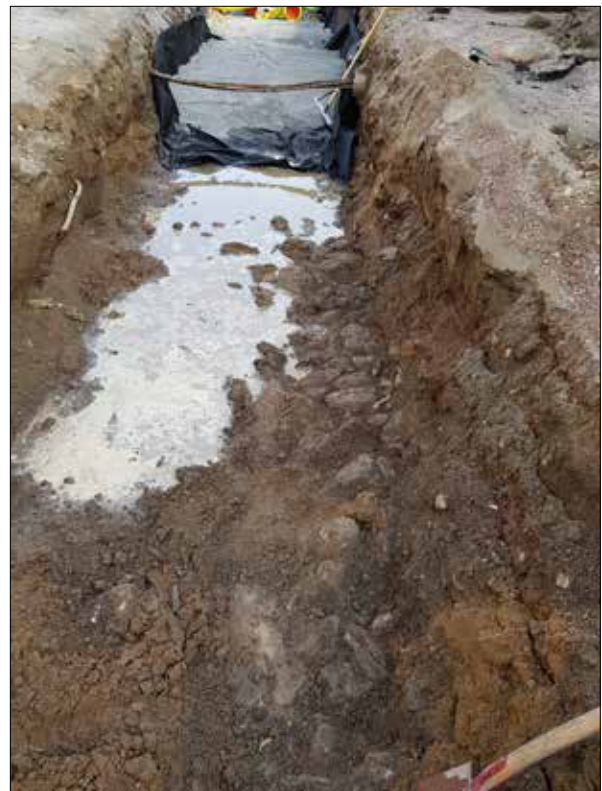
Figur 21. Den stenlagda gatan var framför allt bevarade invid den östra schaktväggen. Vatten som fanns i de äldre matarledningarna som togs bort samlades i schaktets botten. Foto från sydöst.
