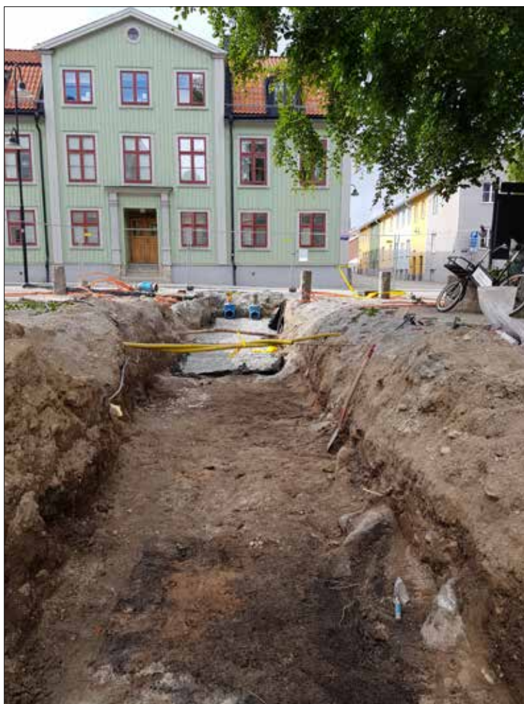
Figur 16. Resterna av hus 2. Till höger i schaktväggen ses syllstenar och i förgrunden platsen för eldstaden. I bakgrunden ses grus som lagts för fyllning till rören. Foto från sydöst.
