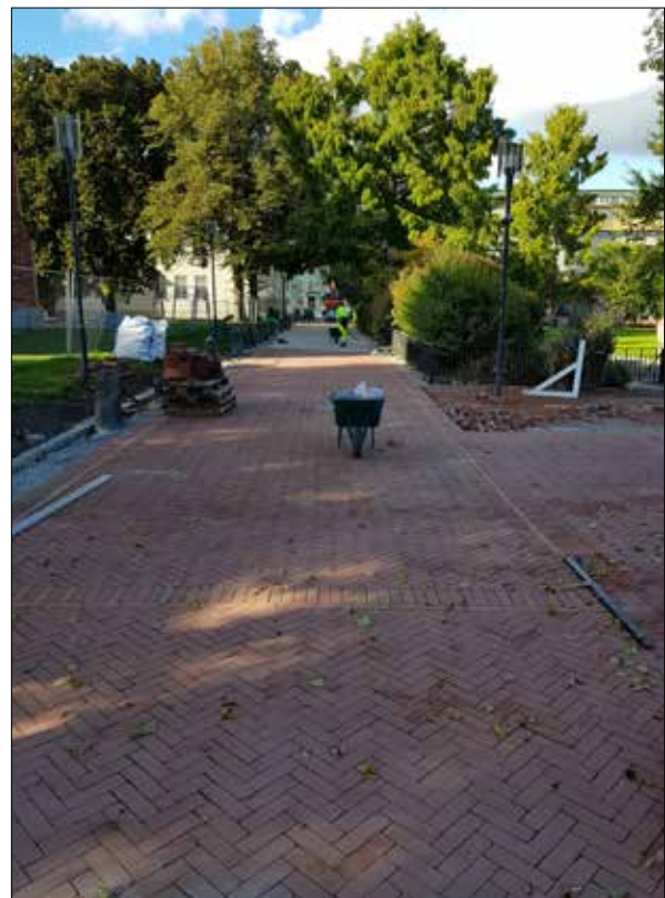
Figur 52. Då ledningarna lagts lades plattor på gång- och cykelvägen. Foto från sydöst.
