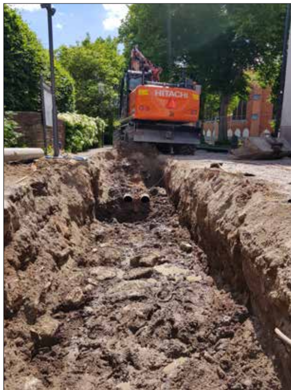
Figur 31. Syllstensrader till hus 4, A27, till höger och hus 5, A28, till vänster. Vattnet rann inte undan innan ledningarna lades ned vilket försvårade undersökningen. Foto från nordväst.
