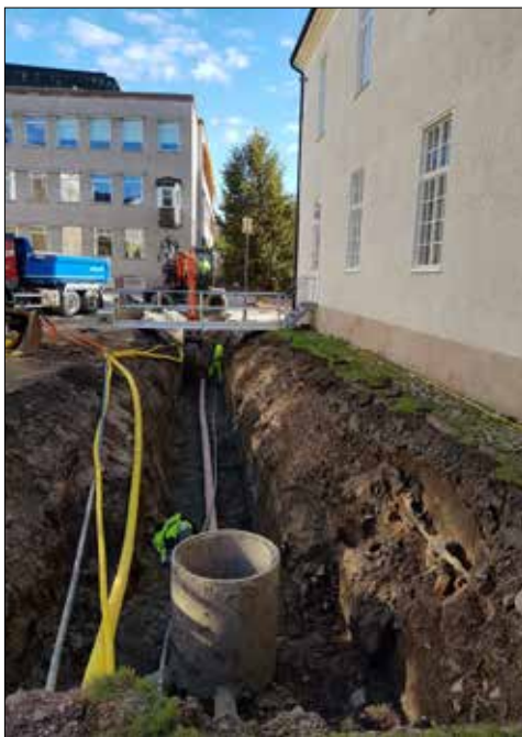
Figur 65. Översikt, schakt 10. Foto från väster.
