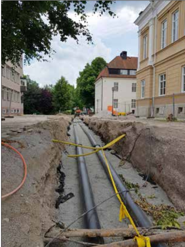
Figur 18. I schaktet lades matarledningar till markvärme ned. Foto från nordväst.
