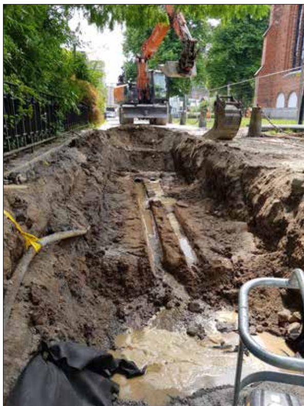
Figur 23. Då de gamla matarledningarna togs bort samlades stora volymer vatten som fanns i ledningarna i schaktet. Foto från nordväst.
