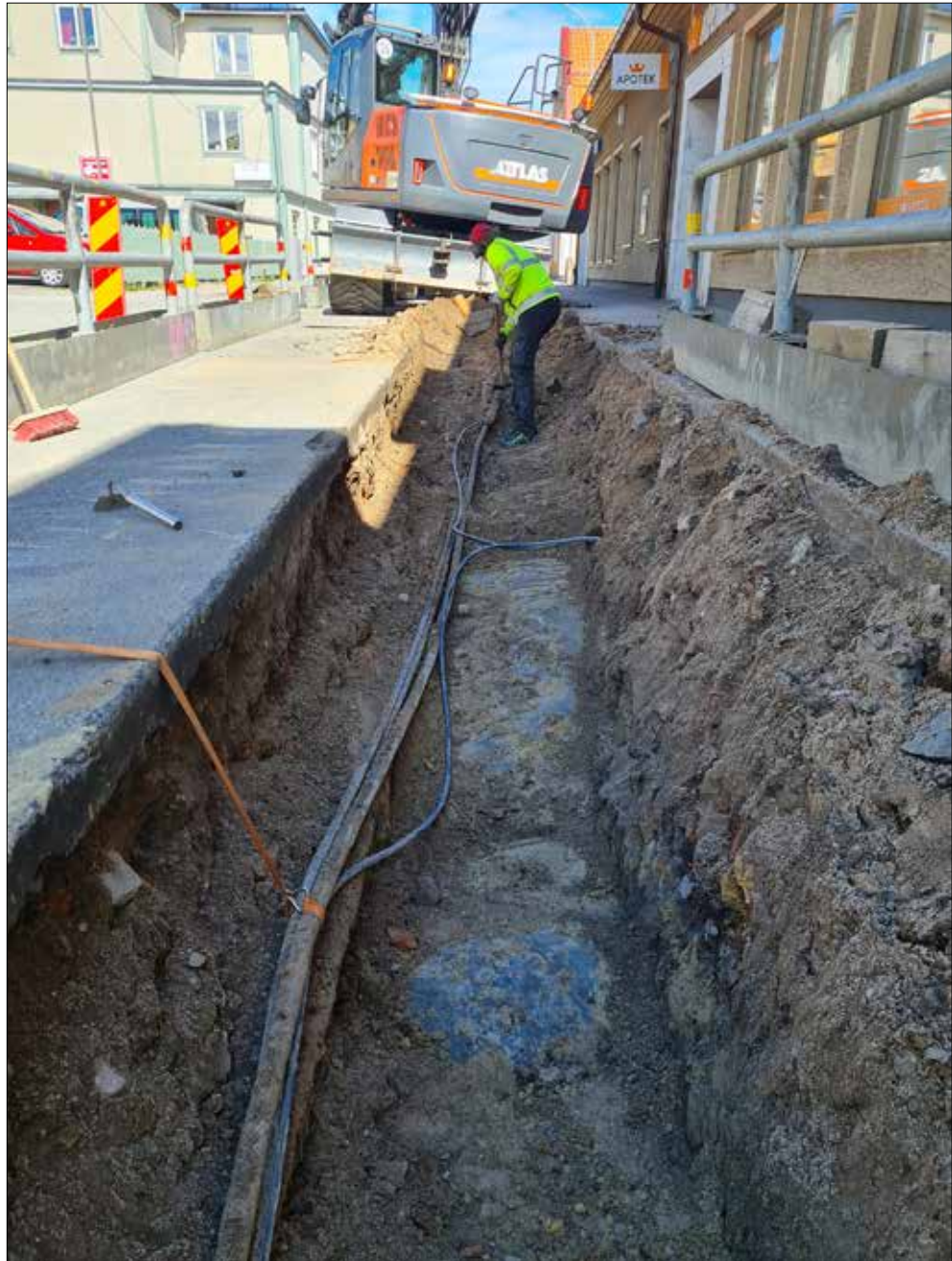
Figur 34. Vid schaktning i Rådhusgatan påträffades berggrunden i Rådhusgatan. Vy från väster.
