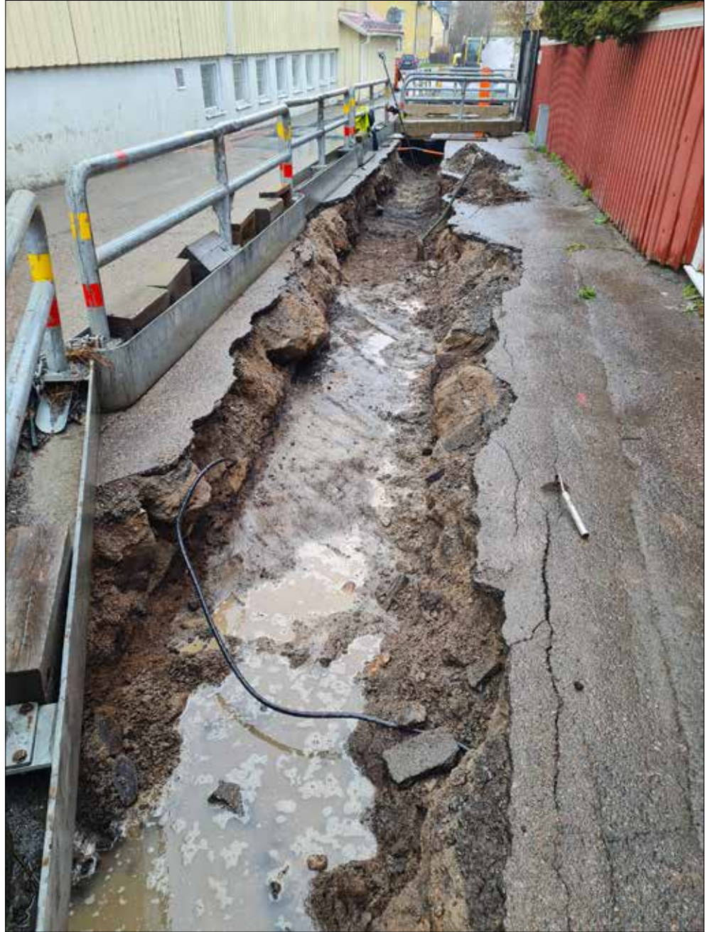
Figur 26. Schakt 4 i Nordanviksgatan, norr om Norra Tullportsgatan. Vänster om gotlandsbackan syns berggrunden blottad. Vy från söder.
