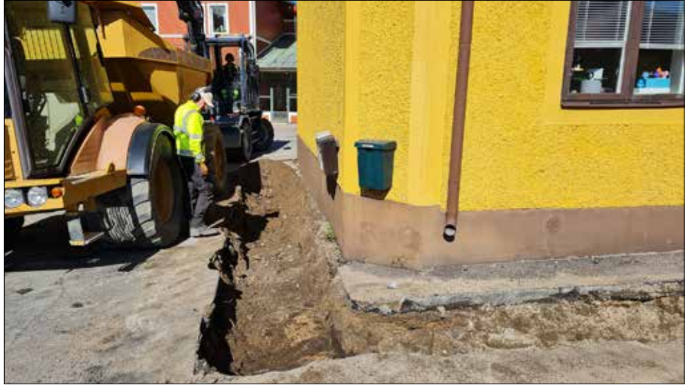
Figur 11. Schakt 1 sett från sydöst. Bakom grävmaskinen skymtar Nordanviksgatan.
