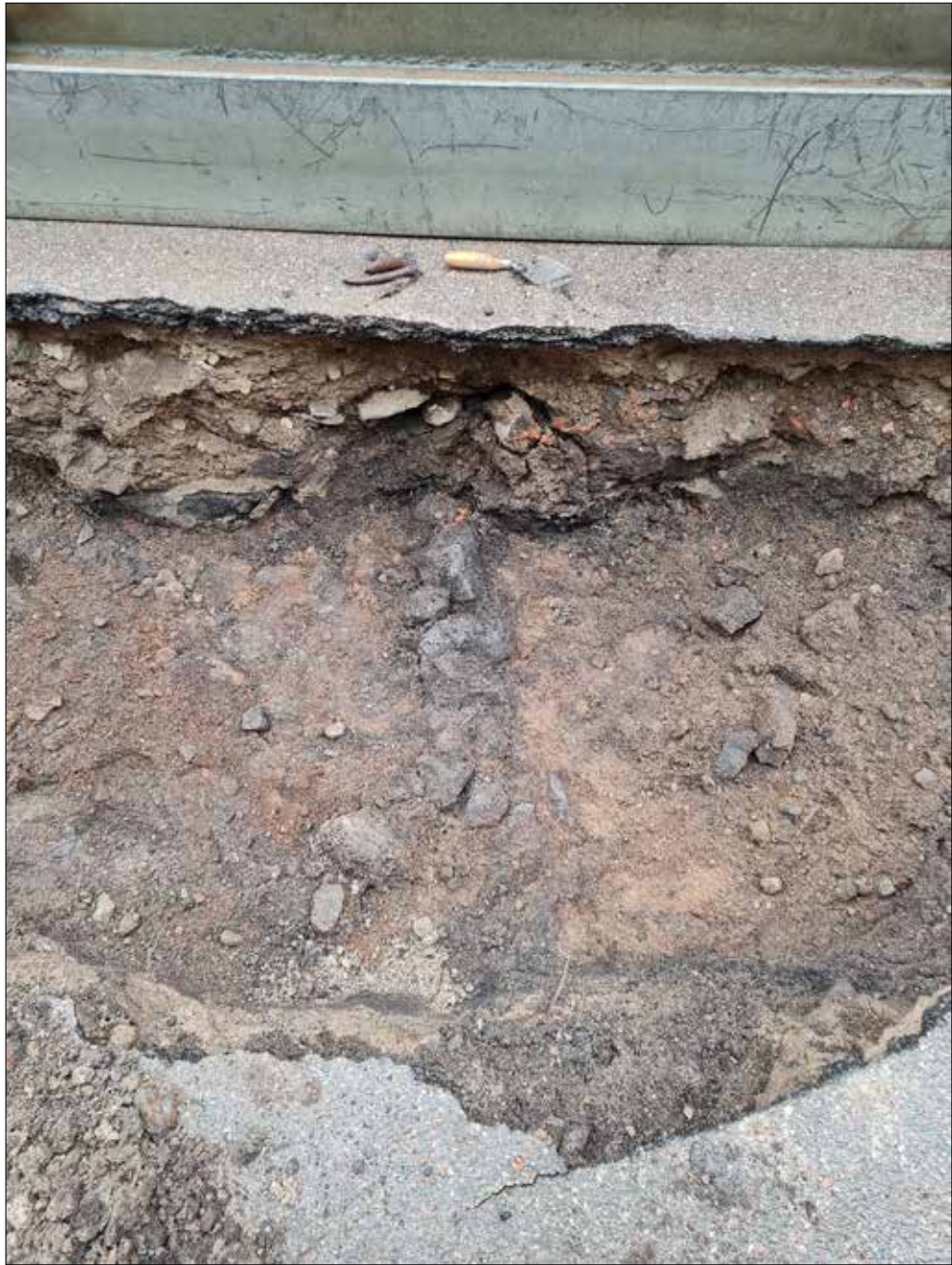
Figur 23. Stenrad A561, här sedd från nordväst, utgjorde möjligen en innervägg mellan två rum i bus 1.
