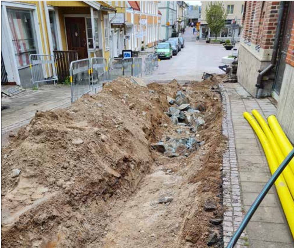
Figur 23. Berggrunden låg endast cirka 0,3 meter under befintlig mark i Drottninggatan direkt söder om Rådhusstorget. Bortanför schaktet syns Rådhusstorget, och efter det fortsätter Drottninggatan mer norr.
