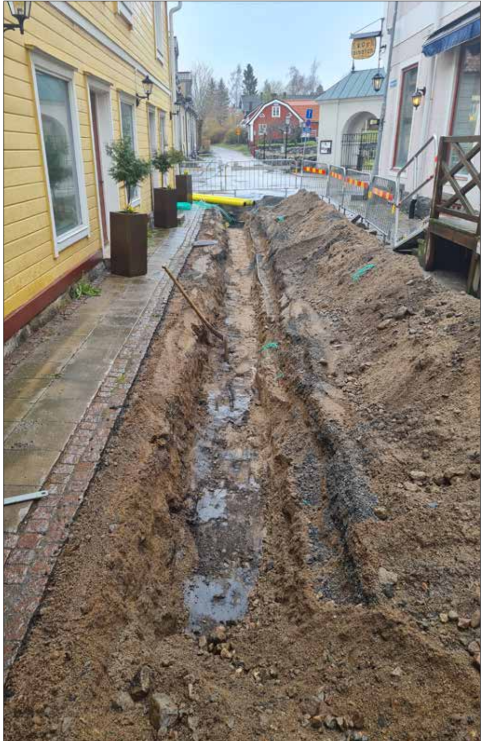
Figur 16. Kulturlager A212 syns som en mörkare färgning i botten av schaktet. Bortanför skyfflen berördes endast moderna fyllnadslager. Fotograferat mot söder. Korsningen mot kyrkogatan syns bakom anspärningen centralt i bild.
