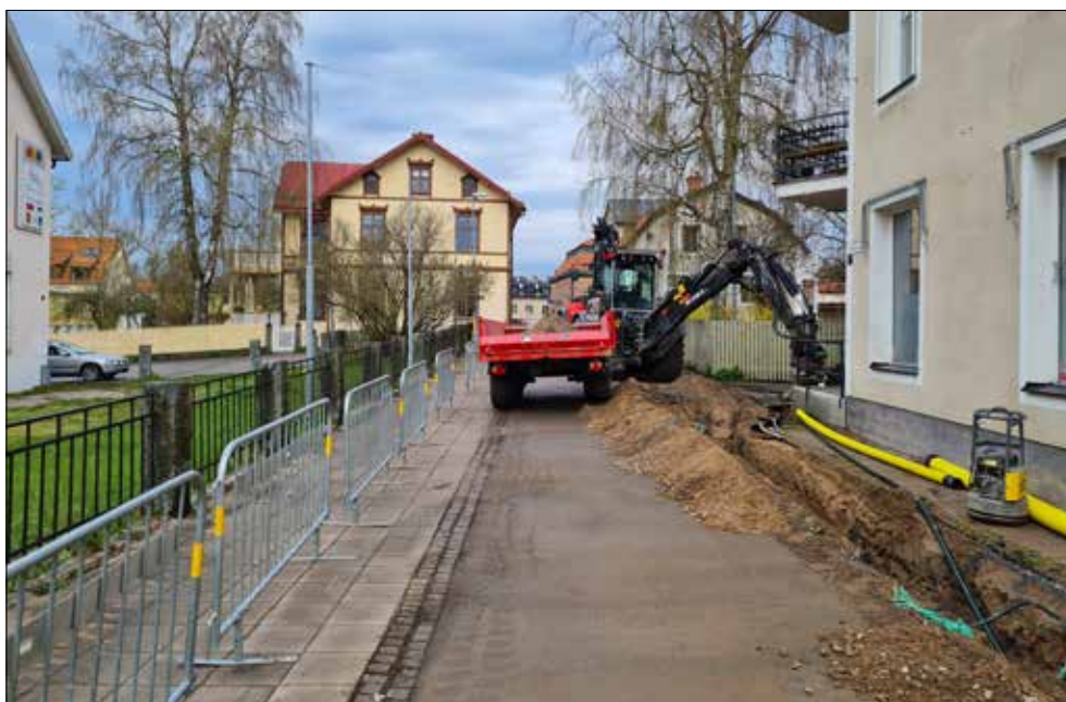
Figur 3. Pågående schaktning i Drottninggatan sett från söder.
