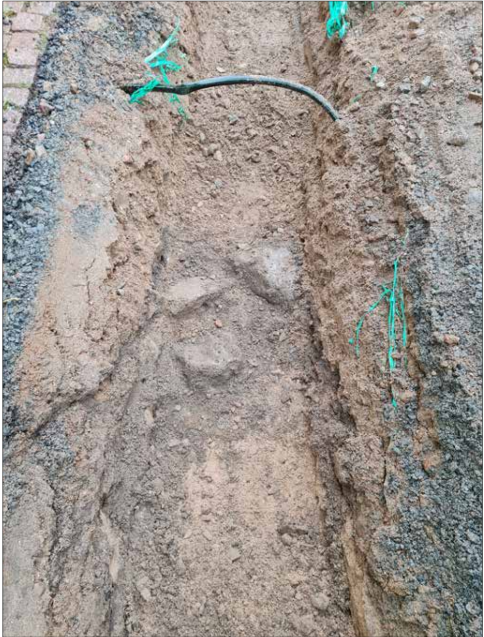
Figur 19. Stenrad A267 sedd från söder. Stenraden var endast bevarad i botten av schaktet.
